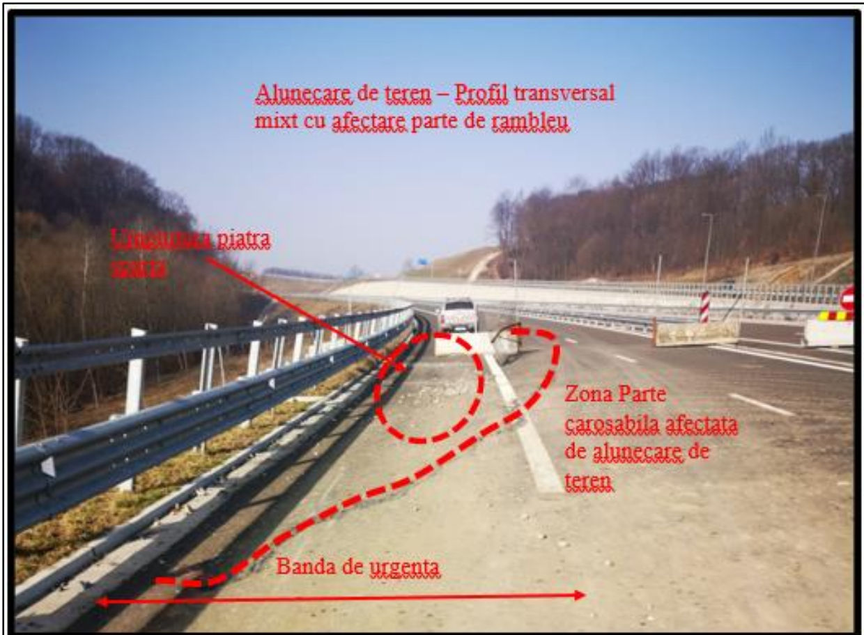
Scanarea a fost realizata pe banda de urgenta afectata de alunecare
